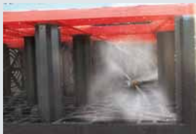
Čištění vsakovací galerie
